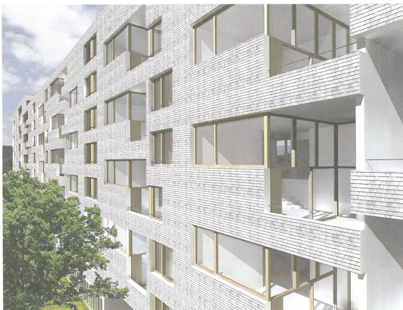
Die Loggien sind auf den Hof nach Osten orientiert.
